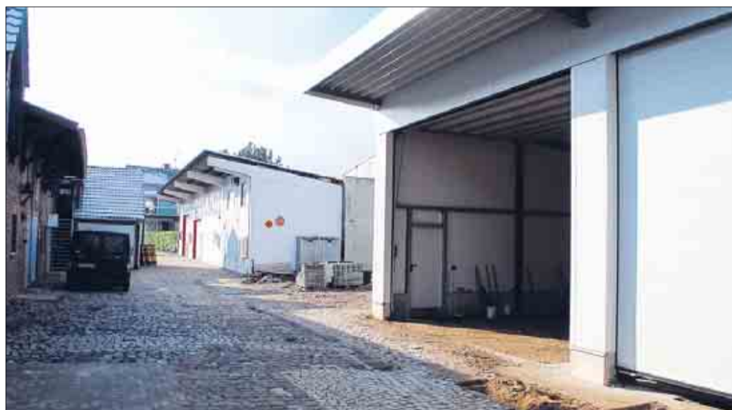
Die Umbaumaßnahmen am Übergangsdomicil in Rheinkassel sind bald abgeschlossen.
